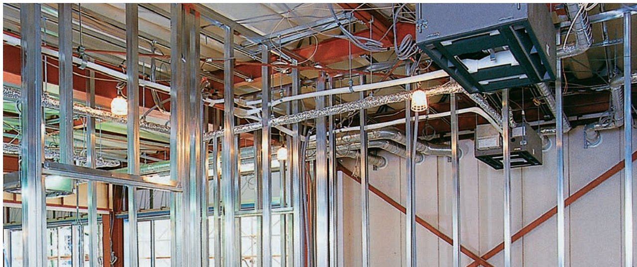
間仕切施工例（角・スタッド）
