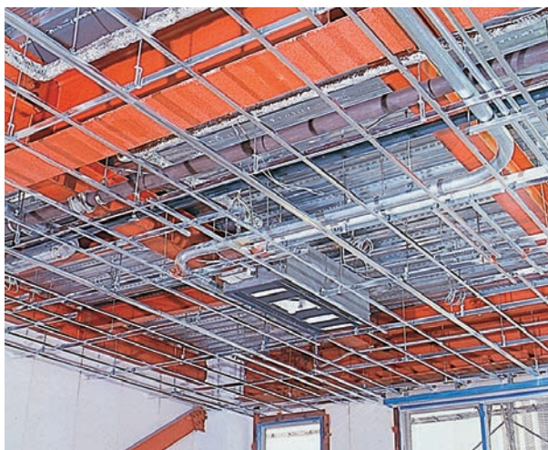
天井下地施工例
