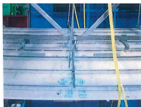
写真-3 破壊状況:野縁受けの曲げ変形
